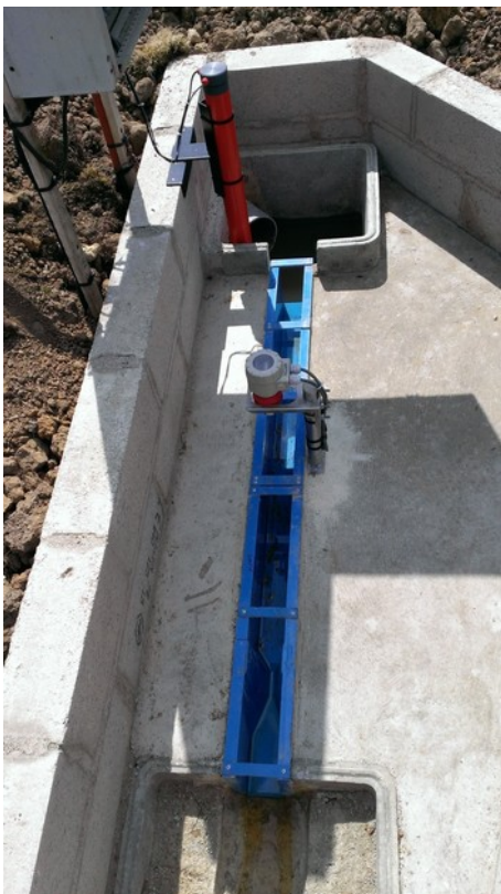
Installationsbeispiel mit Füllstand-/Durchflussmessung und pH-Wert
